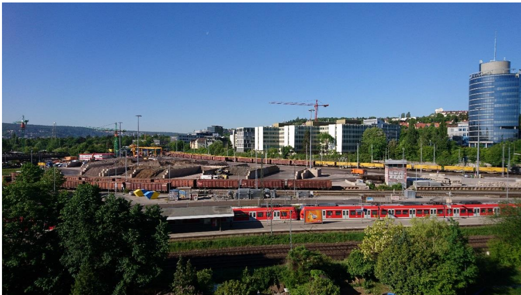
Abbildung 2: Blick auf das Baufeld bei Messende am 07.05.2018
