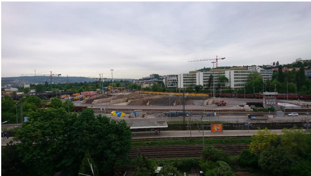
Abbildung 2: Blick auf das Baufeld bei Messende am 30.04.2018
