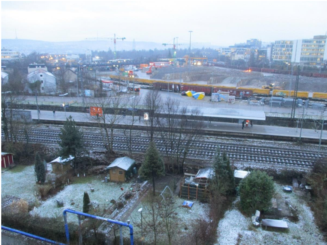
Abbildung 2: Blick auf das Baufeld bei Messende am 22.01.2018
