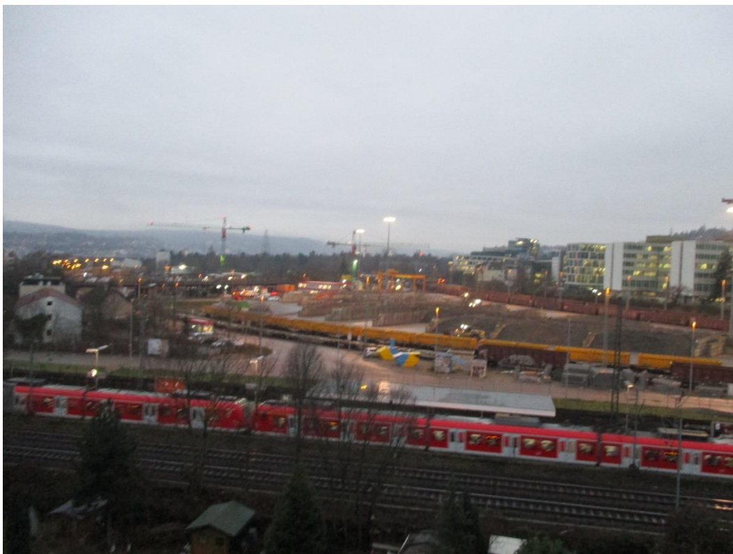
Abbildung 2: Blick auf das Baufeld bei Messende am 21.12.2017
