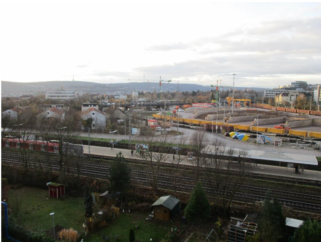
Abbildung 2: Blick auf das Baufeld bei Messende am 27.11.2017
