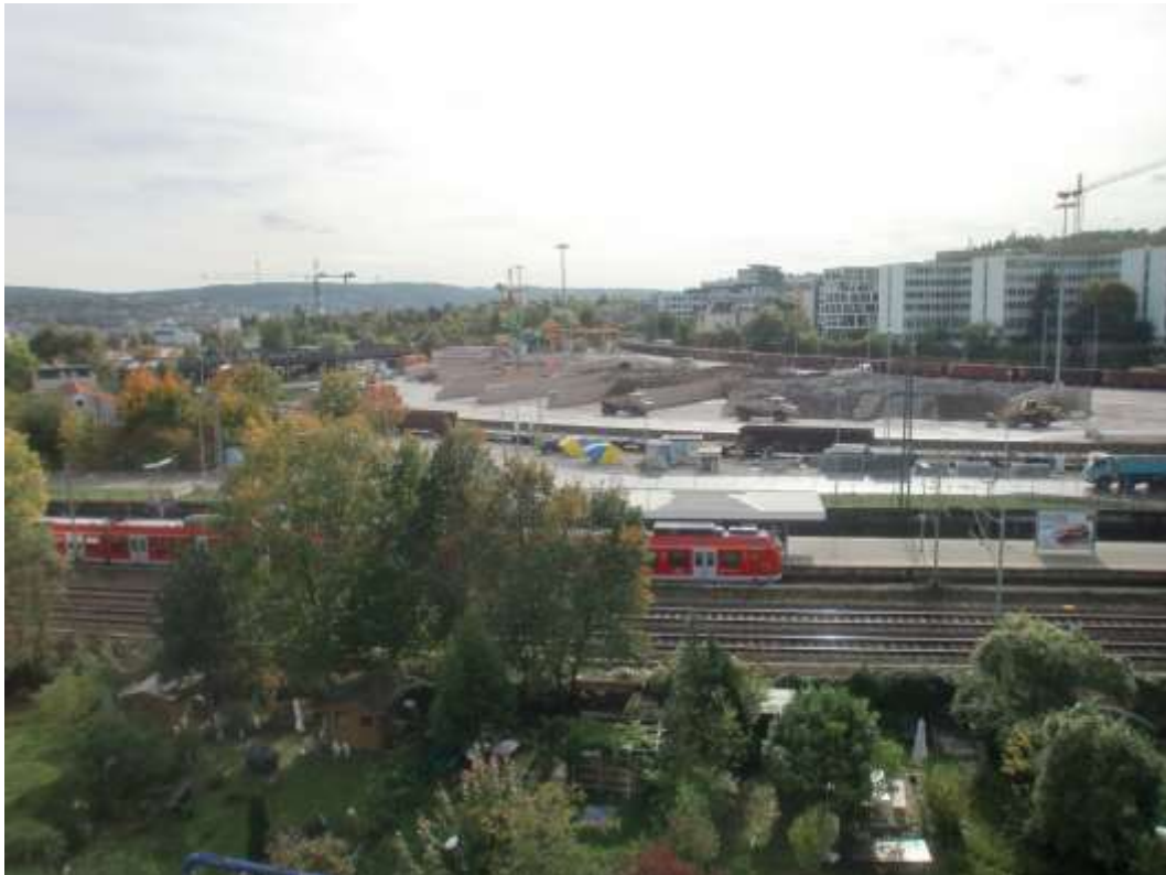
Abbildung 2: Blick auf das Baufeld bei Messende am 04.10.2017
