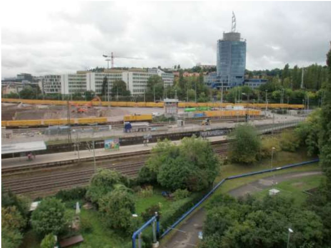
Abbildung 2: Blick auf das Baufeld bei Messende am 18.09.2017
