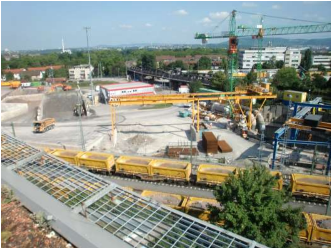
Abbildung 2: Blick auf das Baufeld bei Messende am 28.08.2017
