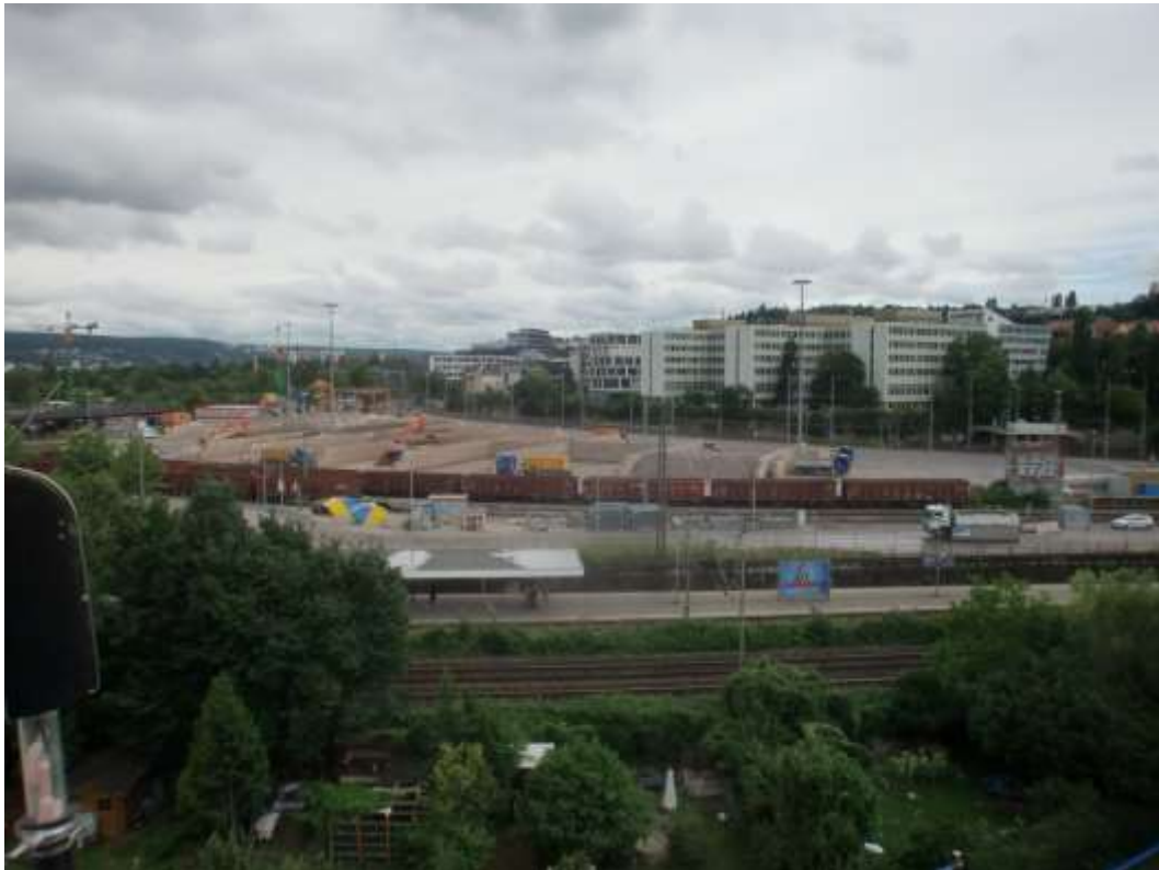
Abbildung 2: Blick auf das Baufeld bei Messende am 24.07.2017
