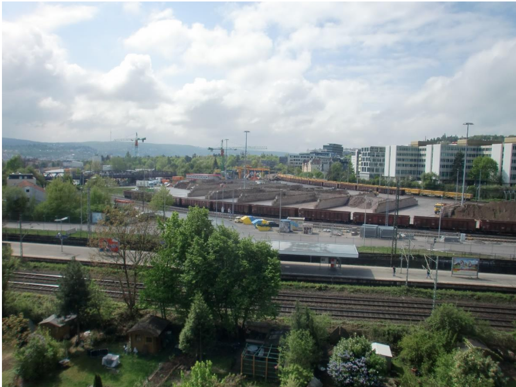
Abbildung 2: Blick auf das Baufeld bei Messende am 18.04.2017
