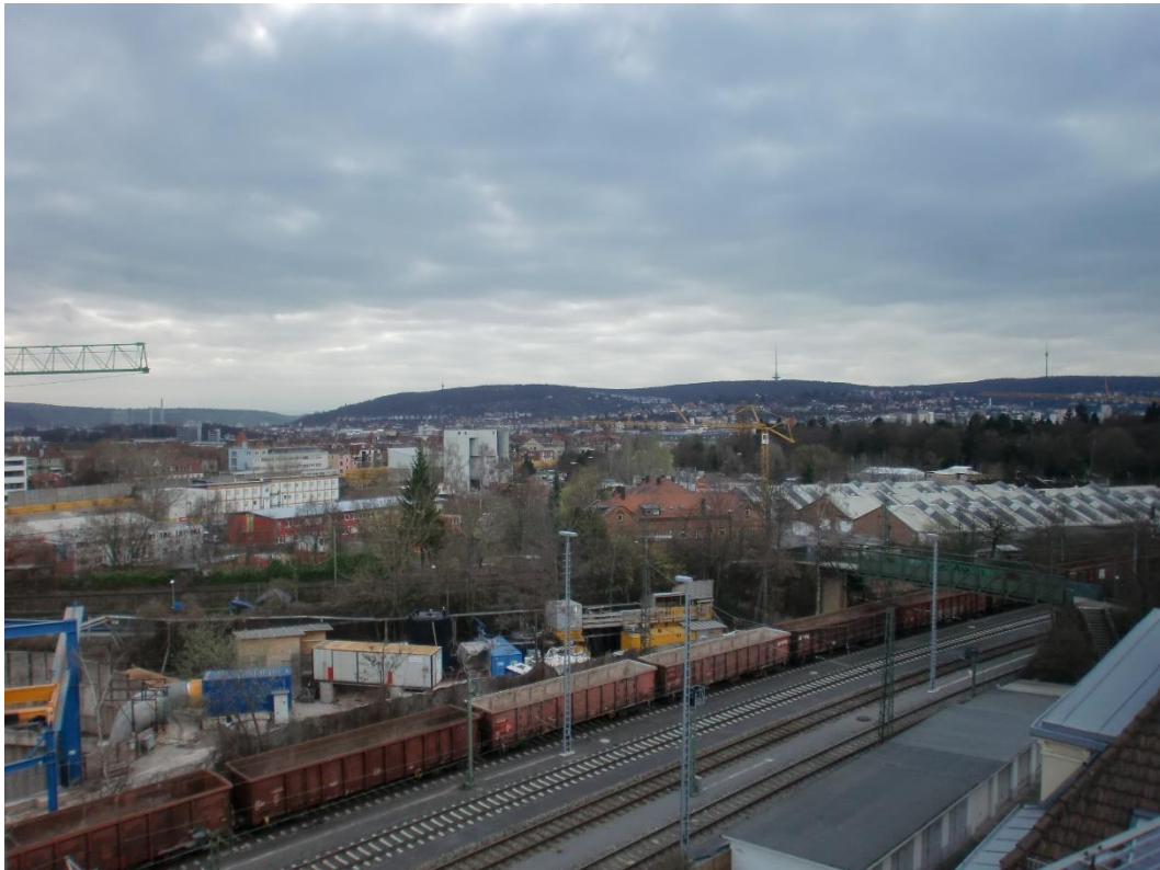
Abbildung 2: Blick auf das Baufeld bei Messende am 20.03.2017
