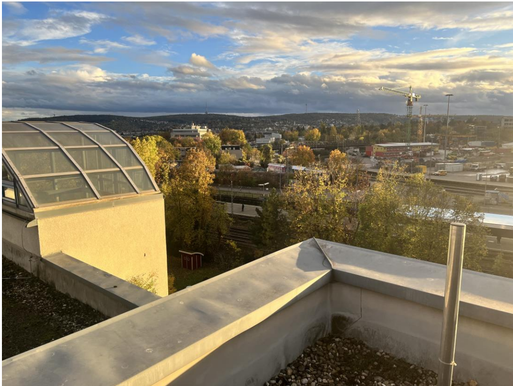
Abbildung 2: Blick auf das Baufeld bei Messende am 06.11.2023
