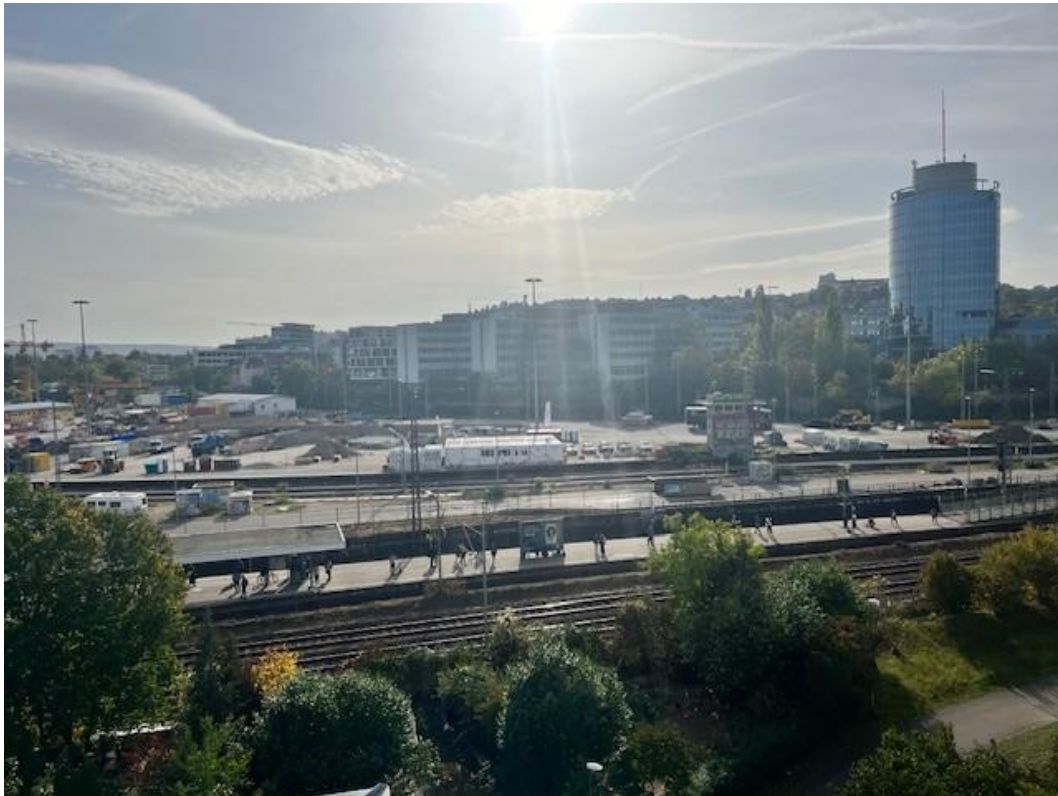
Abbildung 2: Blick auf das Baufeld bei Messende am 09.10.2023
