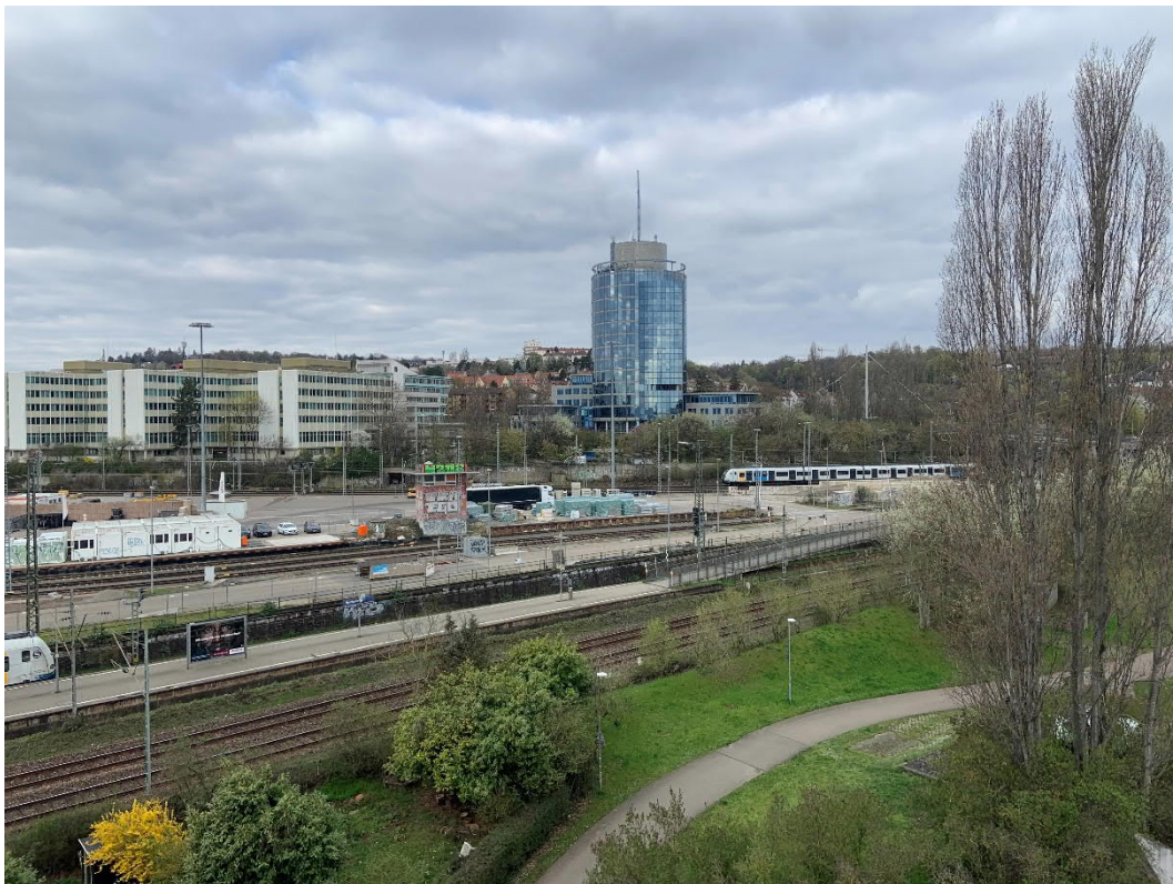
Abbildung 2: Blick auf das Baufeld bei Messende am 10.04.2023
