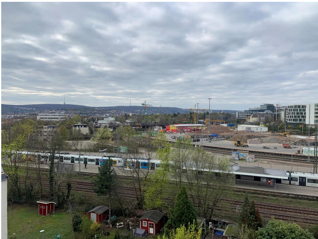
Abbildung 1: Blick auf das Baufeld bei Messbeginn am 03.04.2023
