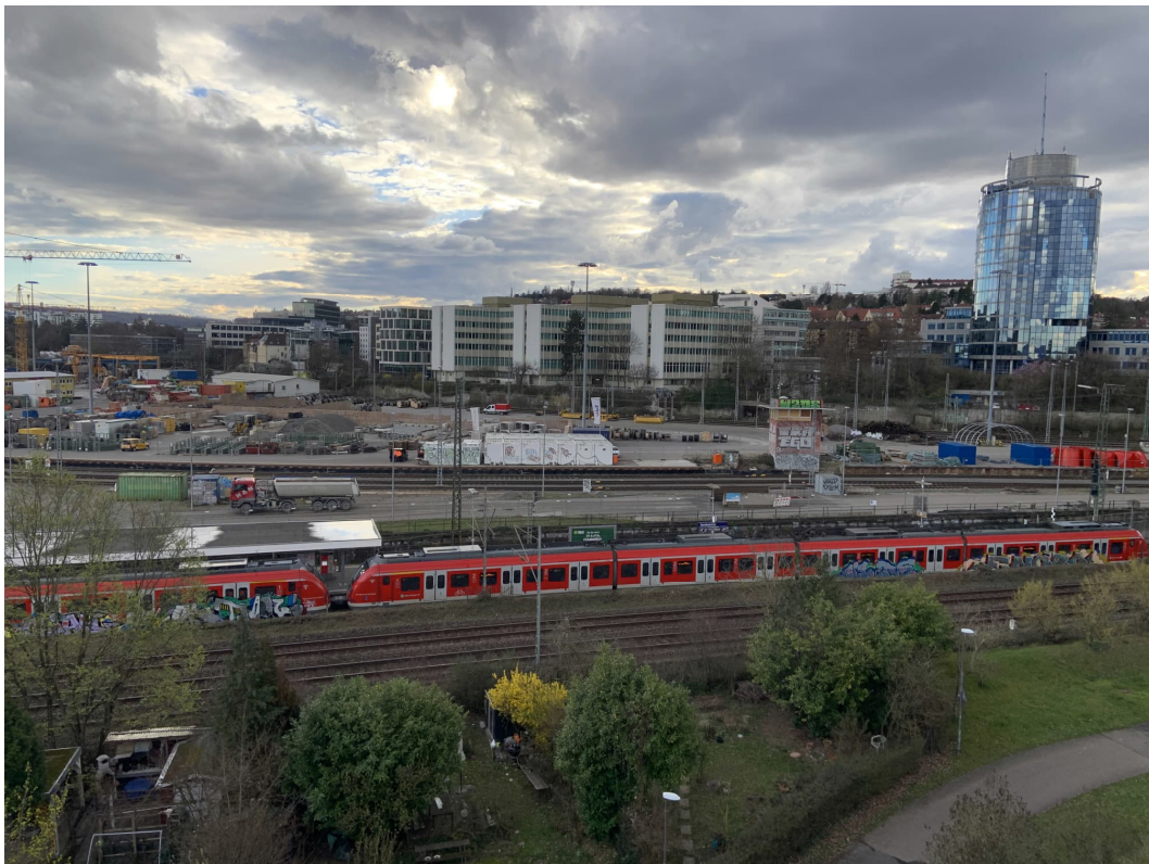
Abbildung 2: Blick auf das Baufeld bei Messende am 11.03.2024
