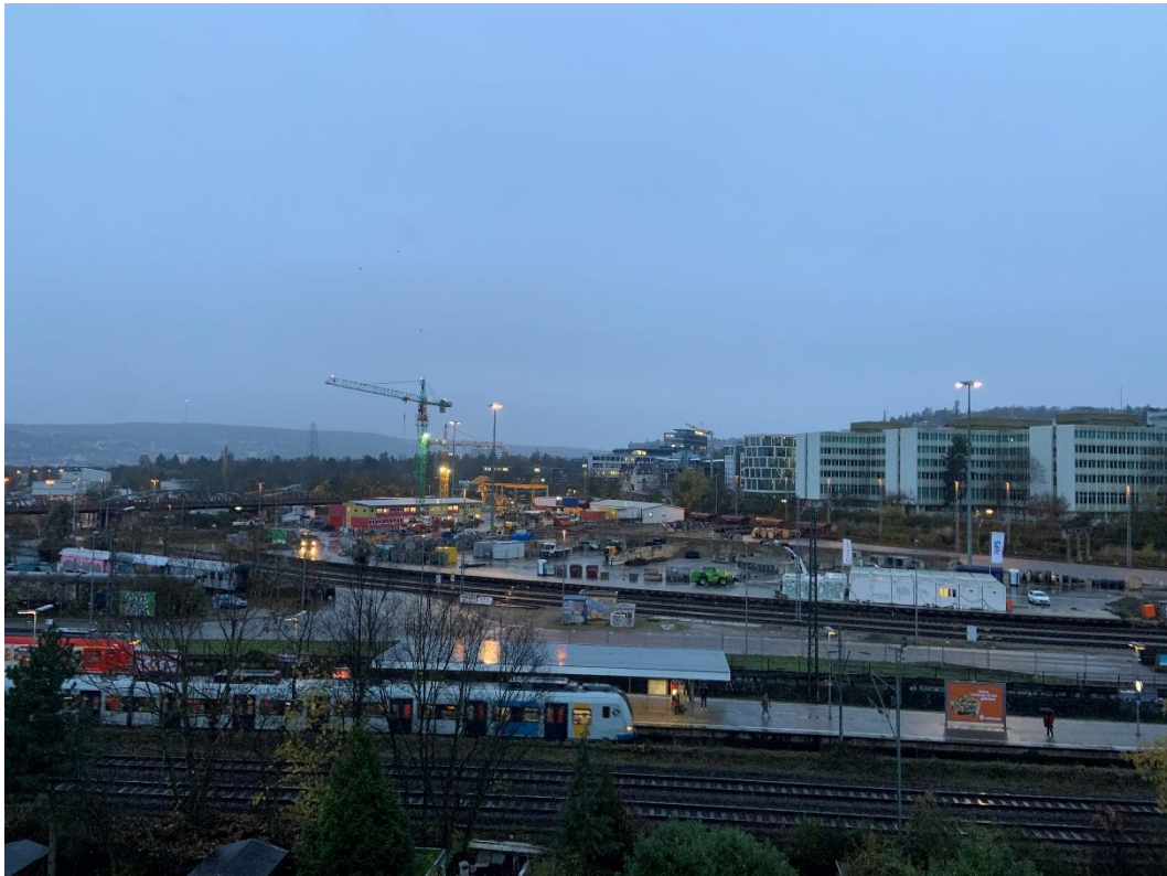
Abbildung 2: Blick auf das Baufeld bei Messende am 27.11.2023
