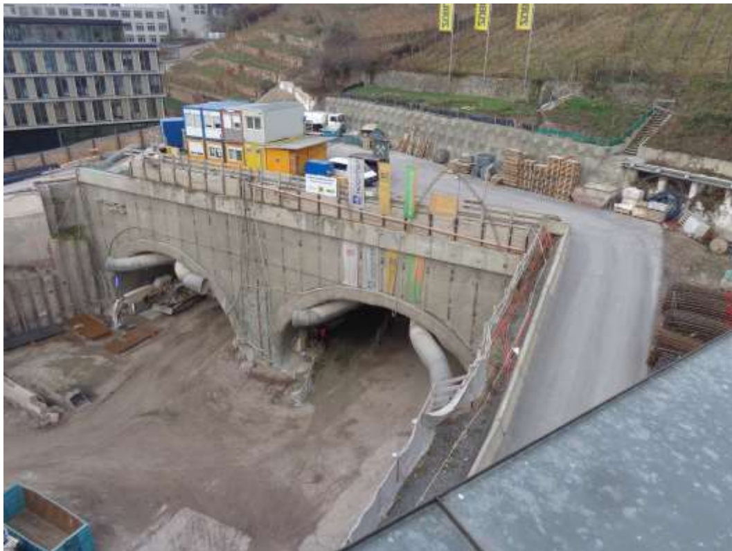
Abbildung 2: Blick auf das Baufeld bei Messende am 01.12.2016
