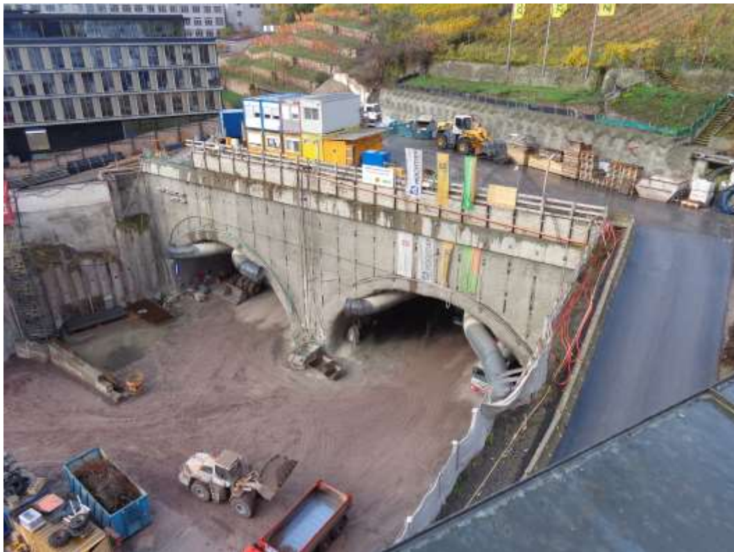
Abbildung 2: Blick auf das Baufeld bei Messende am 10.11.2016
