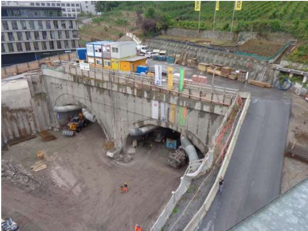
Abbildung 2: Blick auf das Baufeld bei Messende am 19.09.2016
