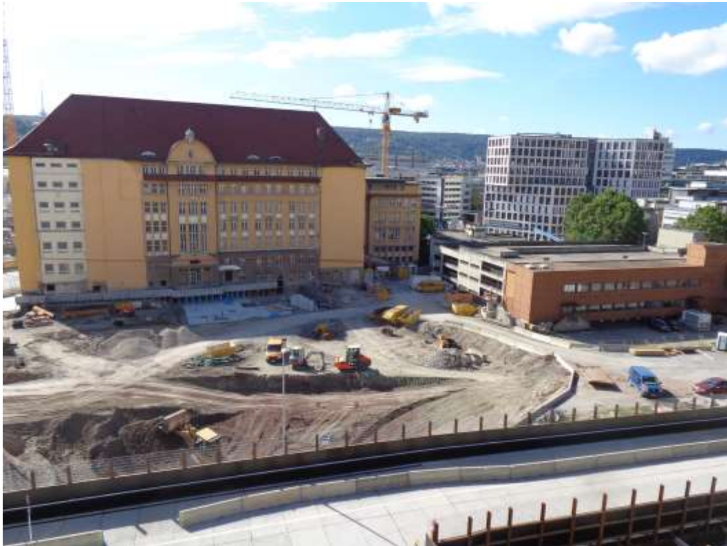
Abbildung 2: Blick auf das Baufeld bei Messende am 22.08.2016
