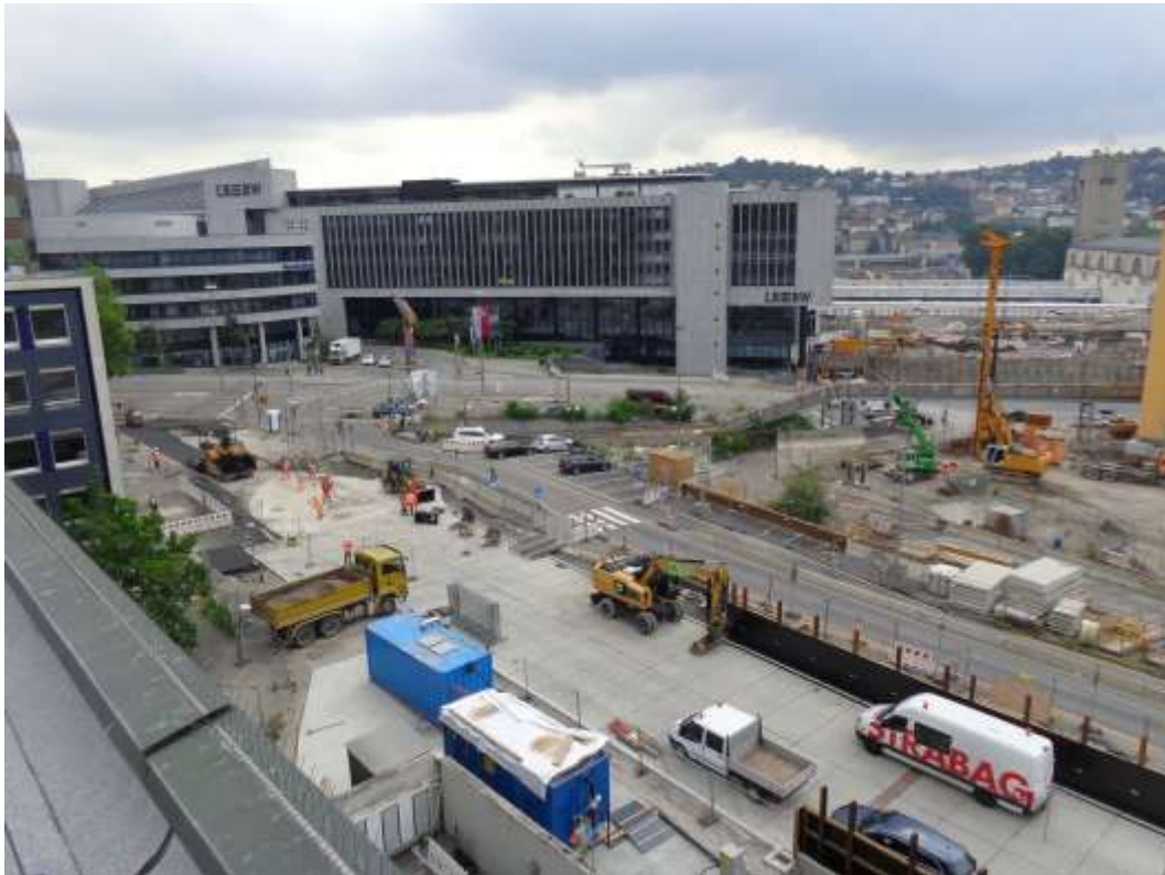
Abbildung 2: Blick auf das Baufeld bei Messende am 25.07.2016
