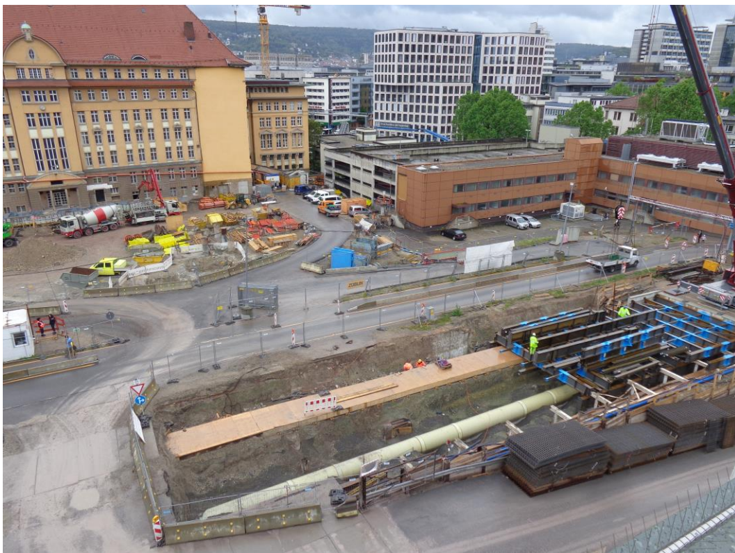
Abbildung 1: Blick auf das Baufeld bei Messende am 23.05.2016
