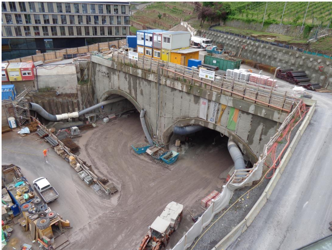
Abbildung 2: Blick auf das Baufeld bei Messende am 30.05.2016
