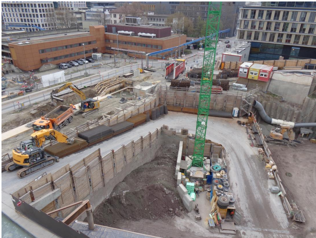
Abbildung 2: Blick auf das Baufeld bei Messende am 04.04.2016
