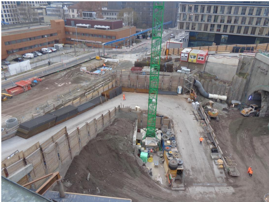
Abbildung 2: Blick auf das Baufeld bei Messende am 29.02.2016
