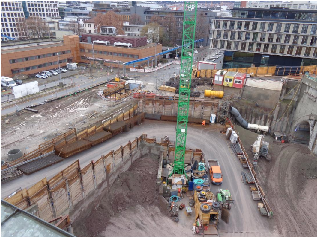
Abbildung 1: Blick auf das Baufeld bei Messbeginn am 11.01.2016
