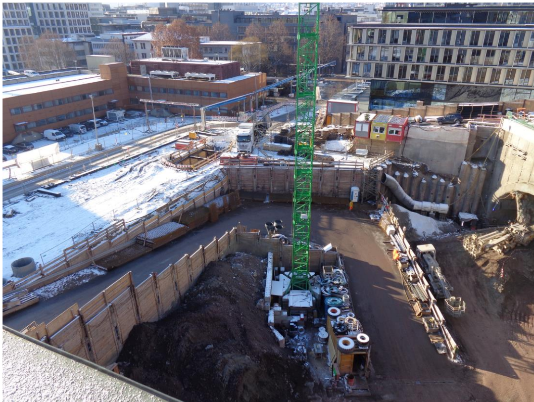
Abbildung 2: Blick auf das Baufeld bei Messende am 18.01.2016
