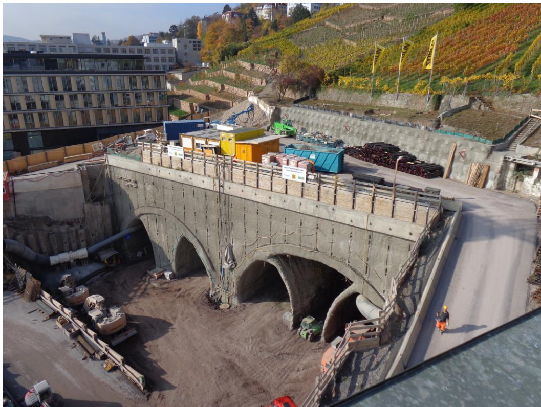
Abbildung 2: Blick auf das Baufeld bei Messende am 26.10.2015
