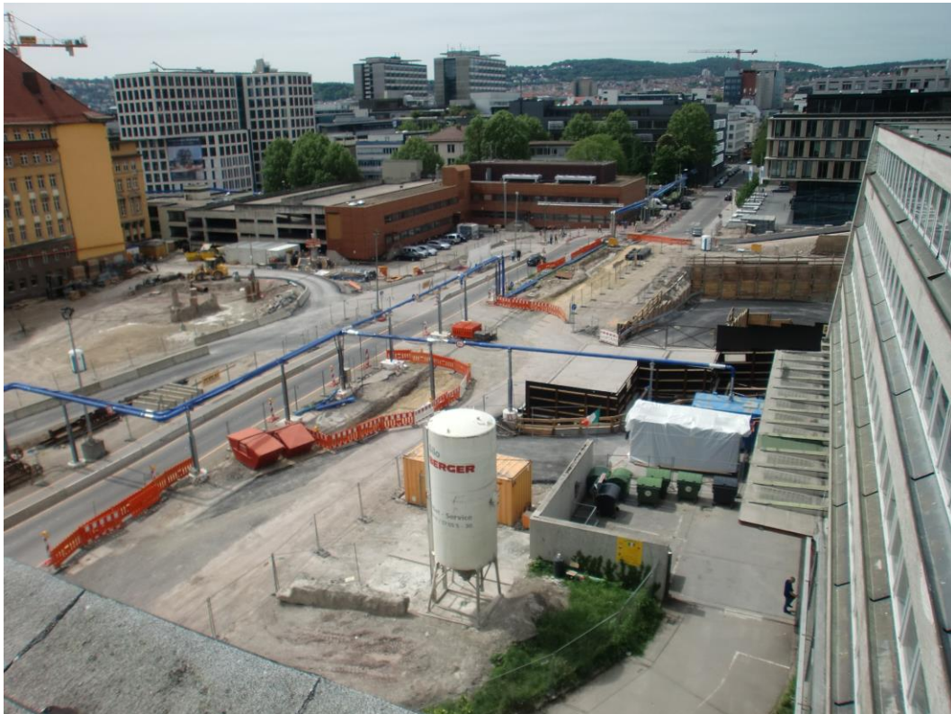
Abbildung 2: Blick auf das Baufeld bei Messende am 11.05.2015
