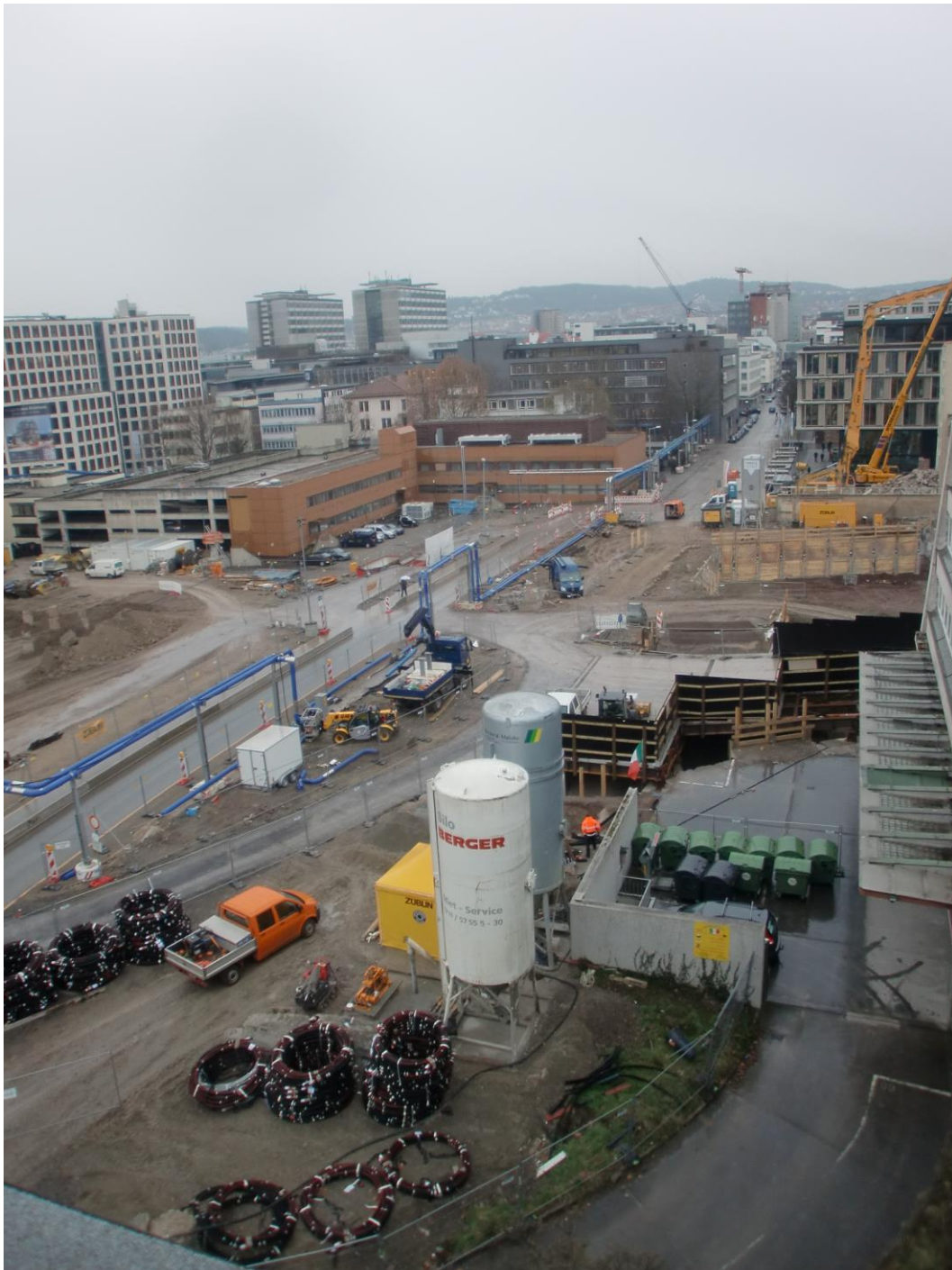
Abbildung 1: Blick auf das Baufeld bei Messbeginn am 23.02.2015
