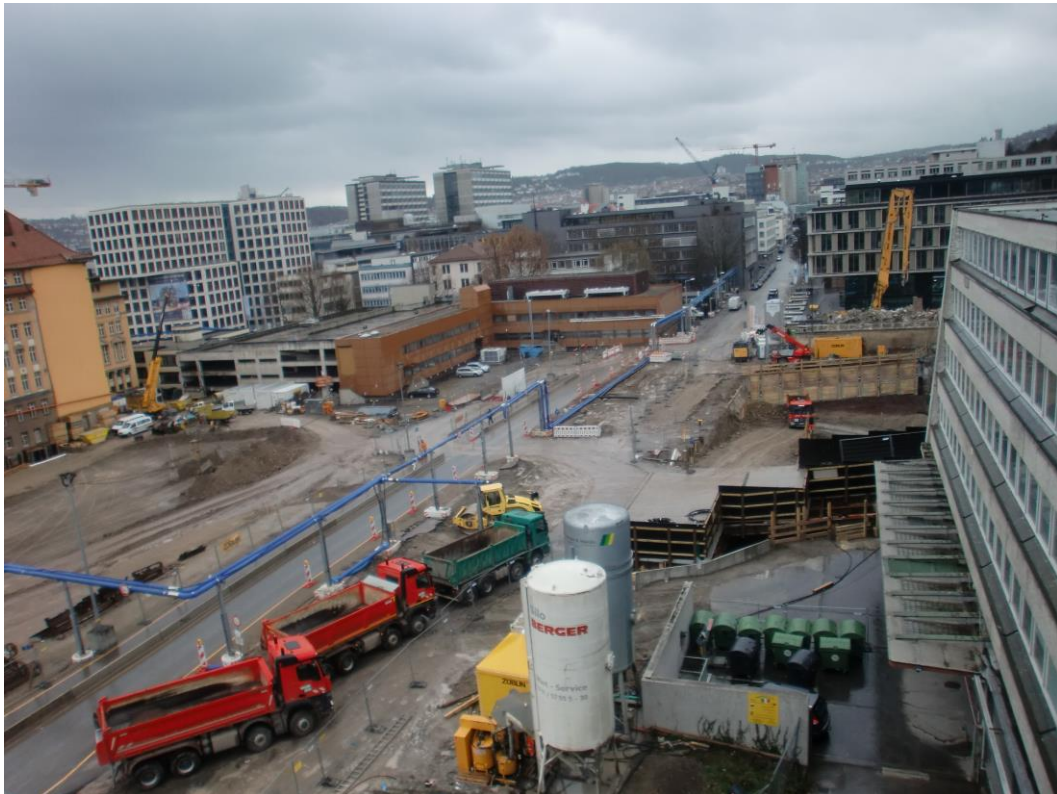
Abbildung 2: Blick auf das Baufeld bei Messende am 02.03.2015
