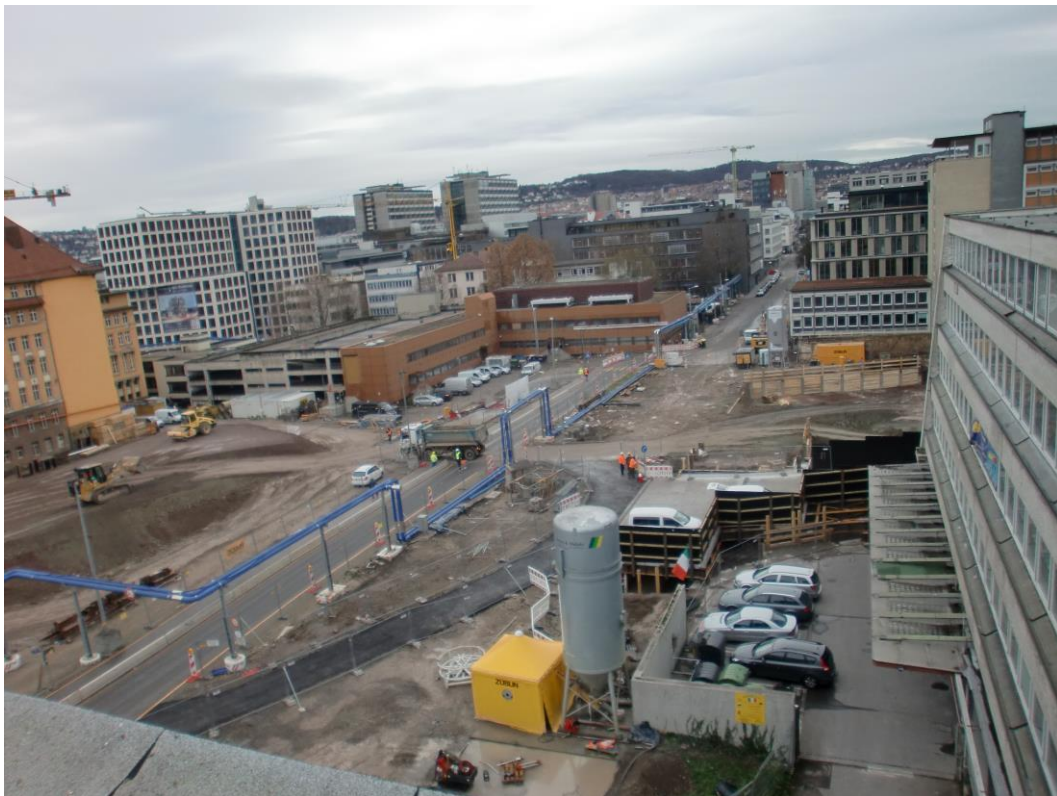
Abbildung 2: Blick auf das Baufeld bei Messende am 11.12.2014
