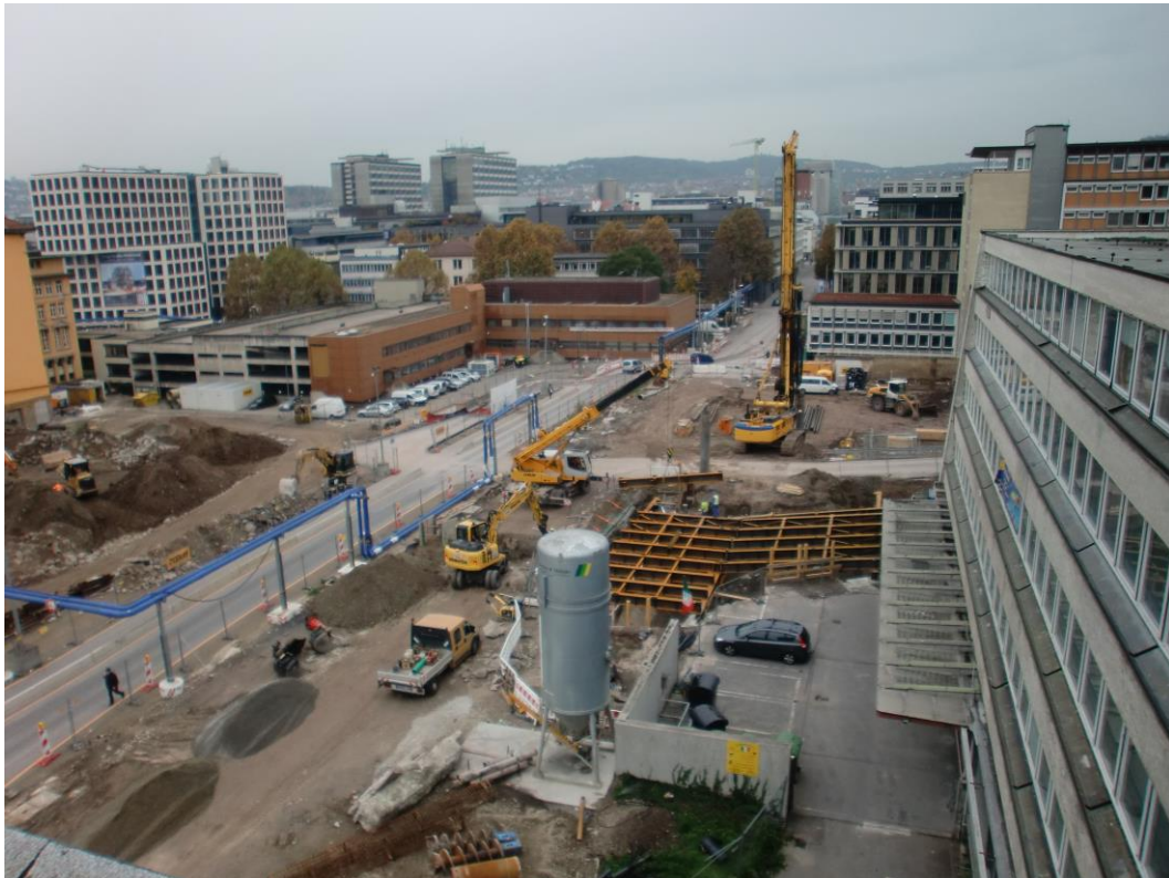
Abbildung 2: Blick auf das Baufeld bei Messende am 03.11.2014
