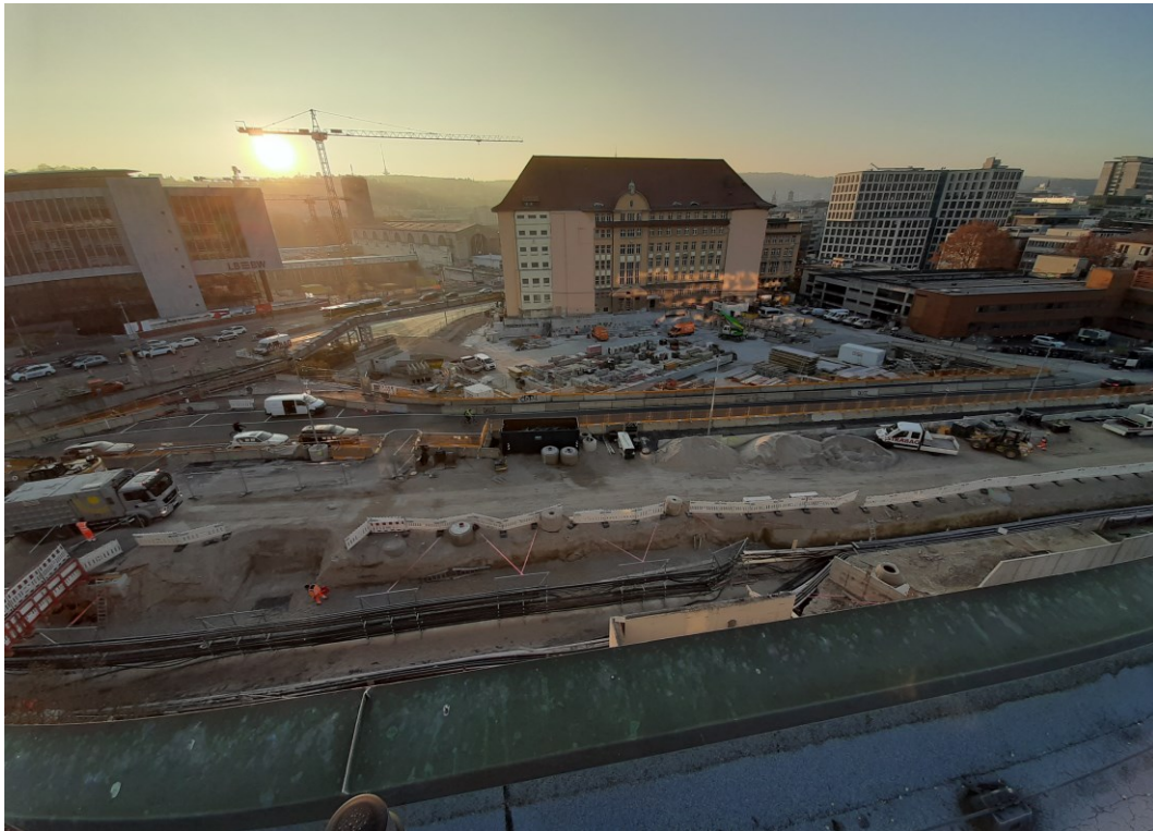
Abbildung 2: Blick auf das Baufeld bei Messende am 01.03.2021
