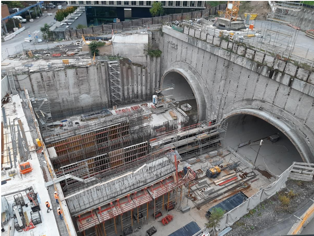
Abbildung 2: Blick auf das Baufeld bei Messende am 19.10.2020
