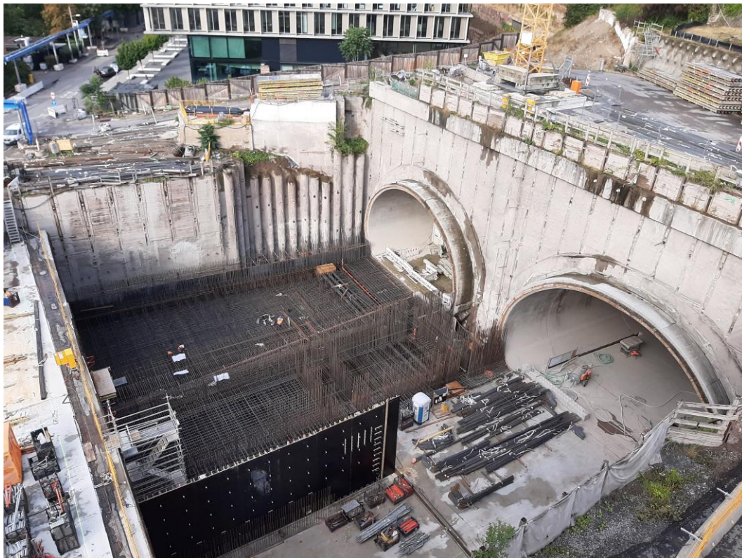
Abbildung 2: Blick auf das Baufeld bei Messende am 17.08.2020
