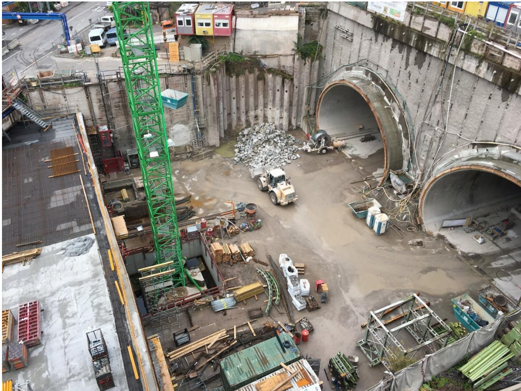
Abbildung 2: Blick auf das Baufeld bei Messende am 07.10.2019
