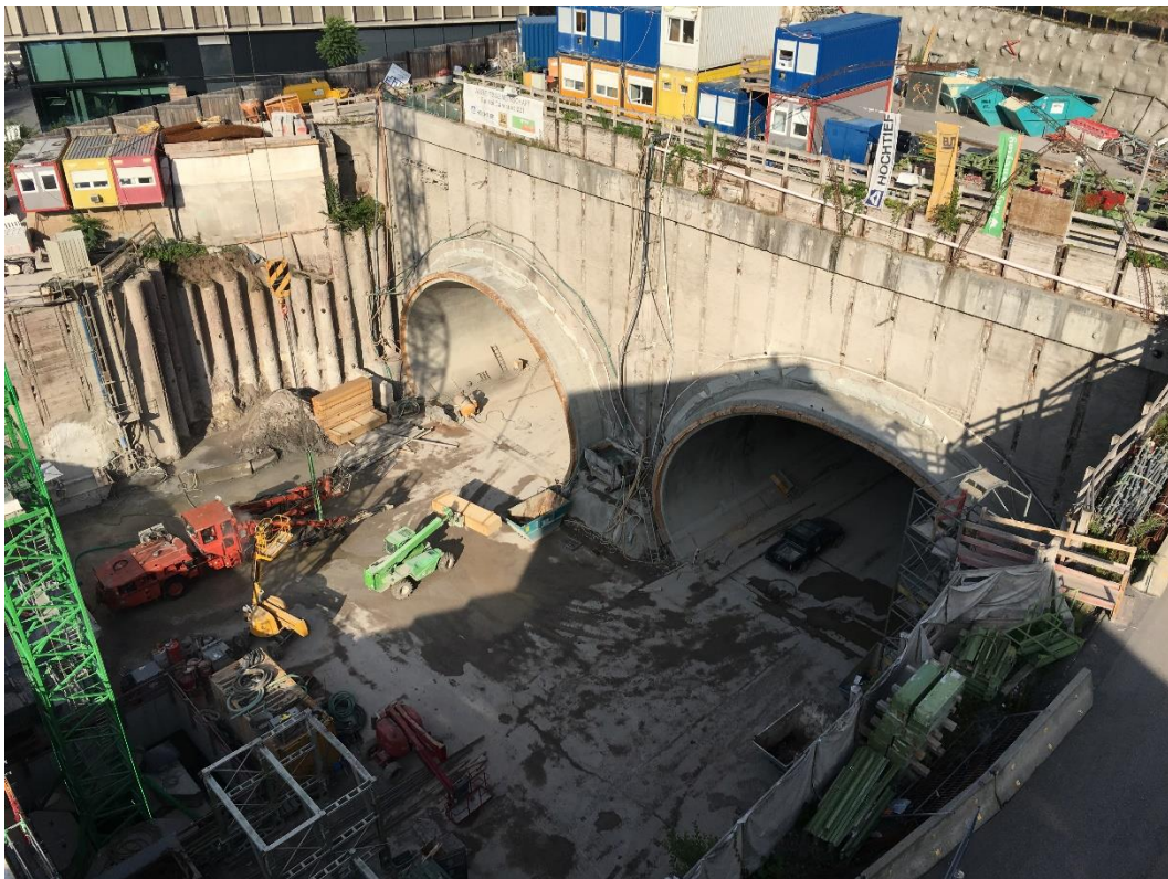
Abbildung 2: Blick auf das Baufeld bei Messende am 06.08.2019
