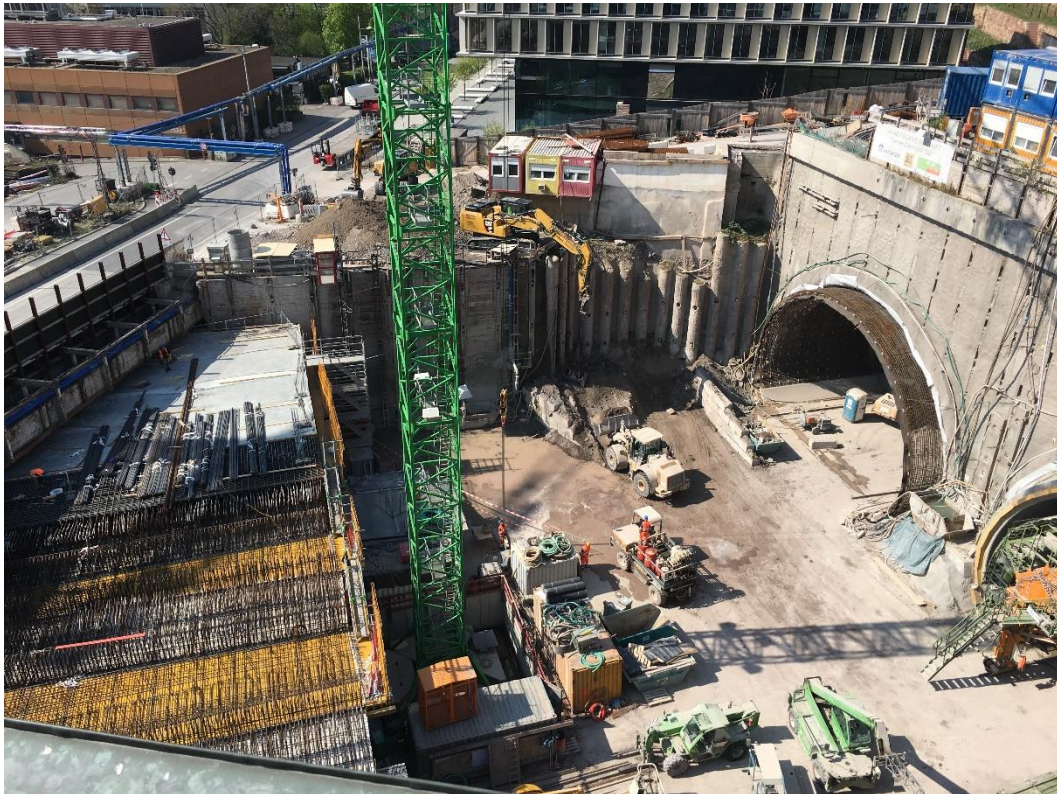
Abbildung 2: Blick auf das Baufeld bei Messende am 16.04.2019
