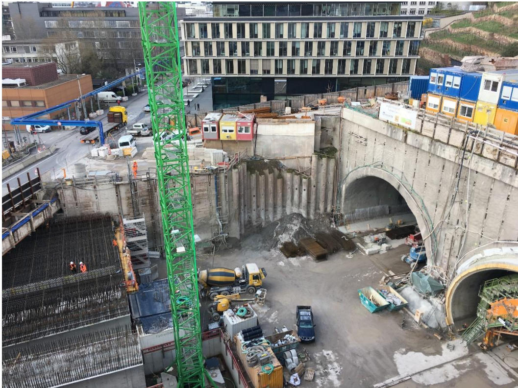
Abbildung 2: Blick auf das Baufeld bei Messende am 19.03.2019
