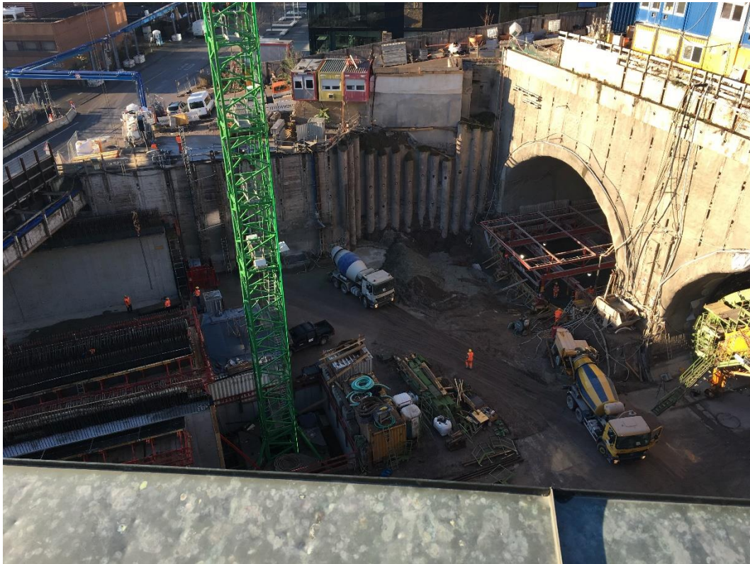
Abbildung 2: Blick auf das Baufeld bei Messende am 18.12.2018
