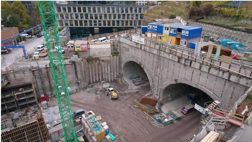
Abbildung 2: Blick auf das Baufeld bei Messende am 30.10.2018
