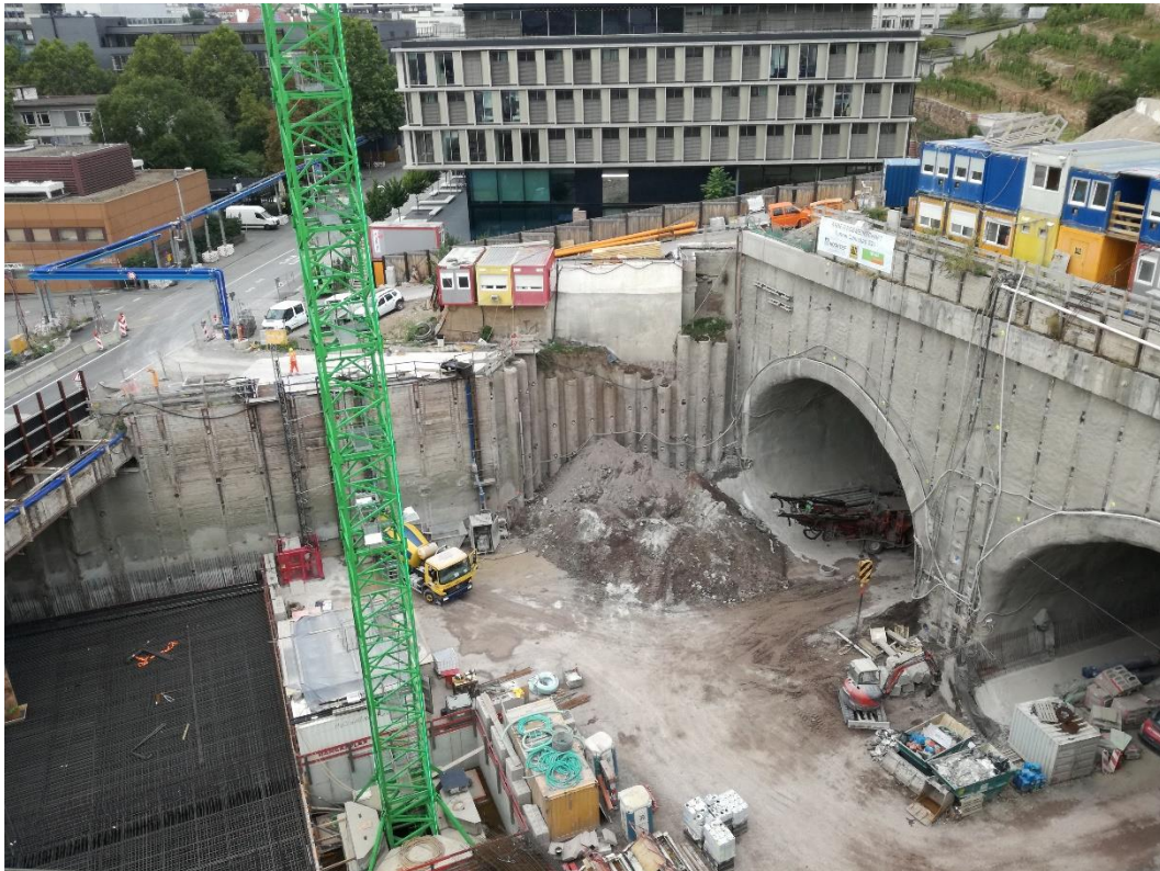
Abbildung 2: Blick auf das Baufeld bei Messende am 27.08.2018
