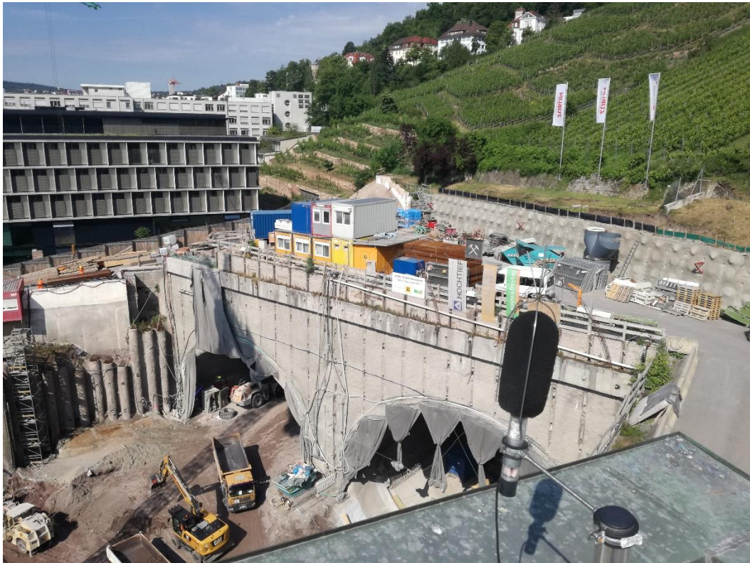
Abbildung 2: Blick auf das Baufeld bei Messende am 21.05.2017
