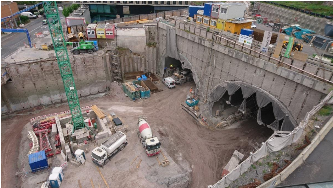
Abbildung 2: Blick auf das Baufeld bei Messende am 23.04.2017
