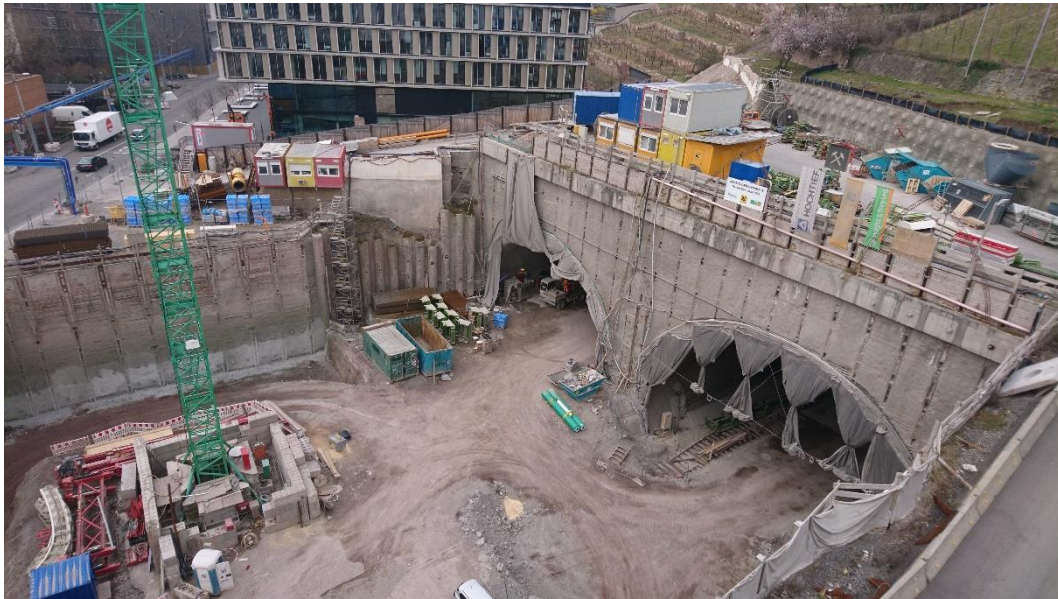
Abbildung 2: Blick auf das Baufeld bei Messende am 26.03.2017
