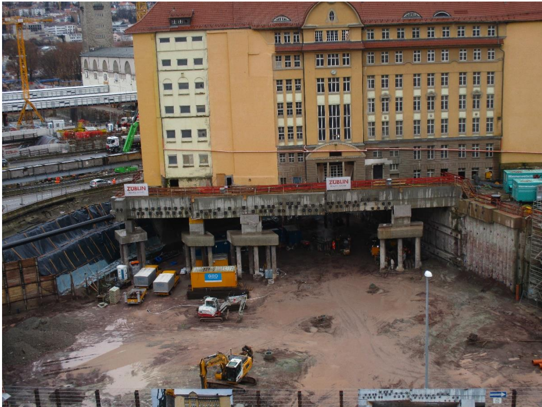
Abbildung 2: Blick auf das Baufeld bei Messende am 11.12.2017
