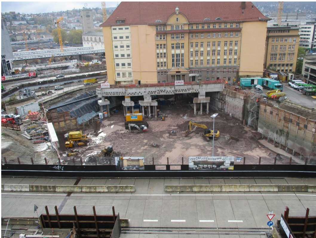
Abbildung 2: Blick auf das Baufeld bei Messende am 13.11.2017
