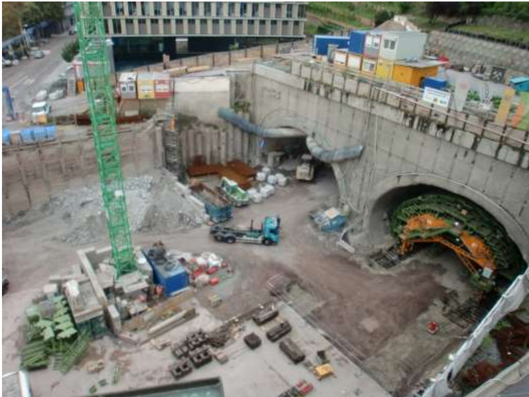
Abbildung 2: Blick auf das Baufeld bei Messende am 11.09.2017
