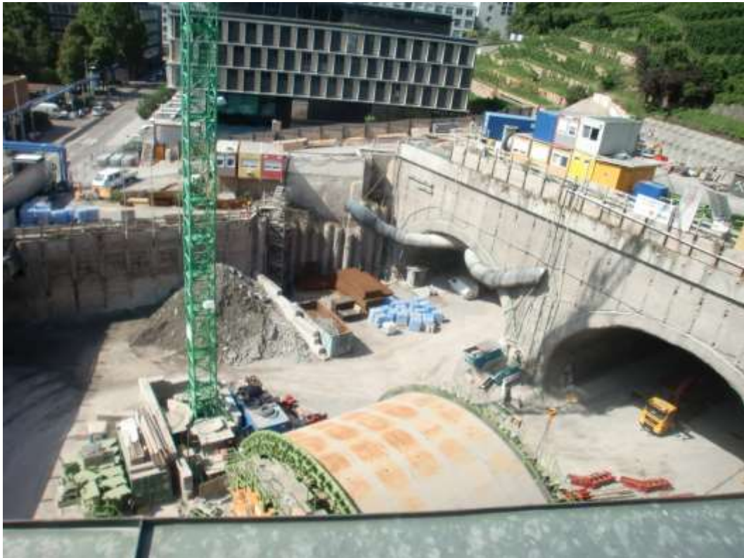
Abbildung 2: Blick auf das Baufeld bei Messende am 22.08.2017
