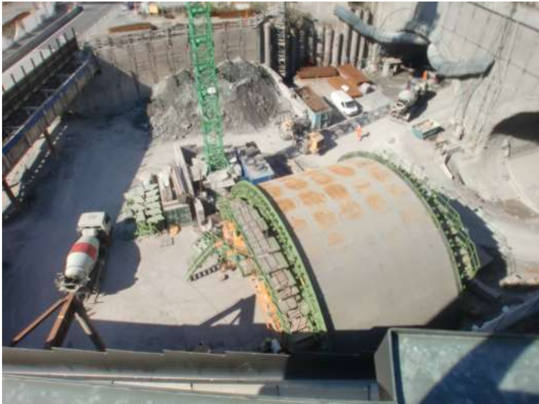
Abbildung 2: Blick auf das Baufeld bei Messende am 07.08.2017
