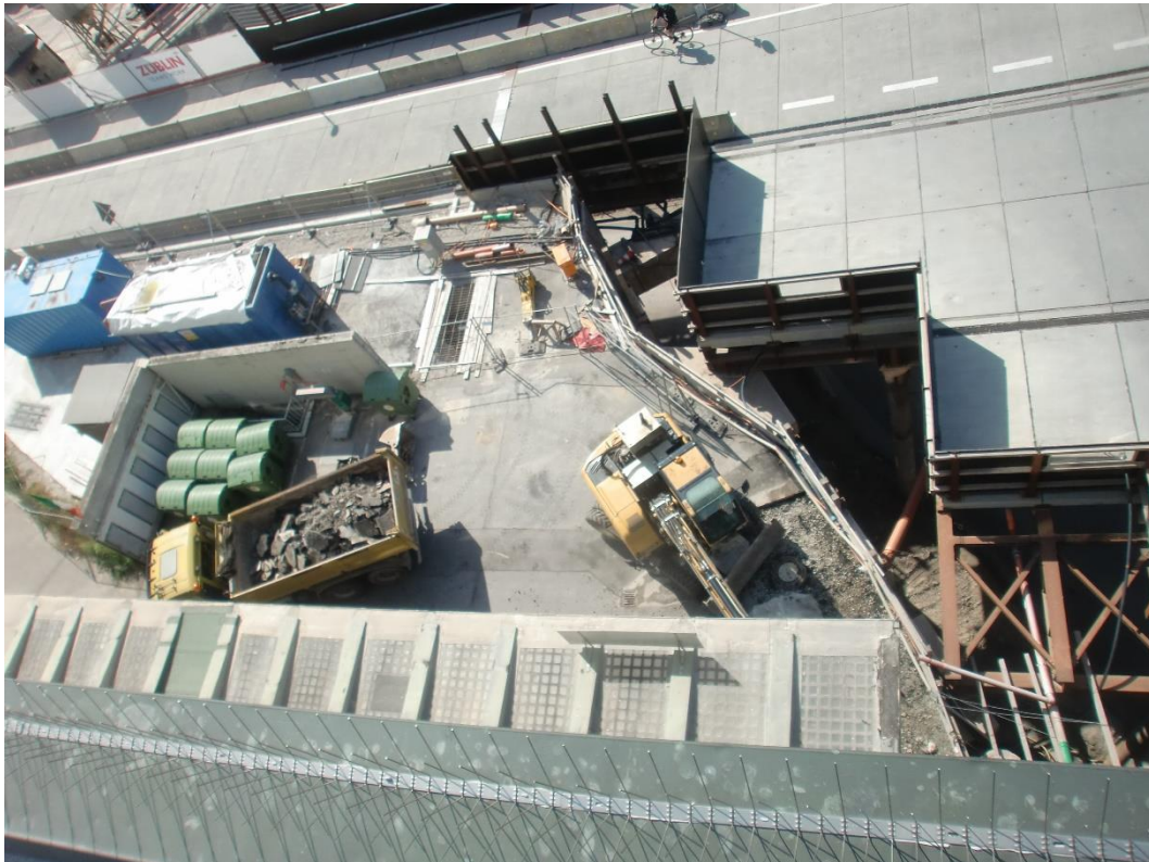
Abbildung 2: Blick auf das Baufeld bei Messende am 29.05.2017
