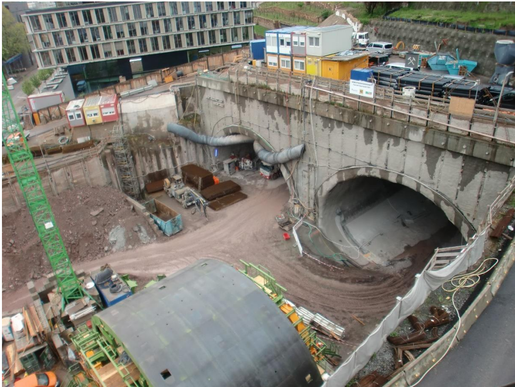
Abbildung 2: Blick auf das Baufeld bei Messende am 02.05.2017
